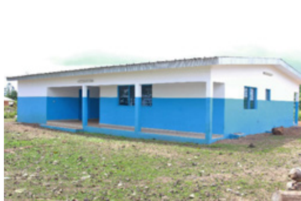
Photo 8 : Une maternité construite et équipée à Djapadji
