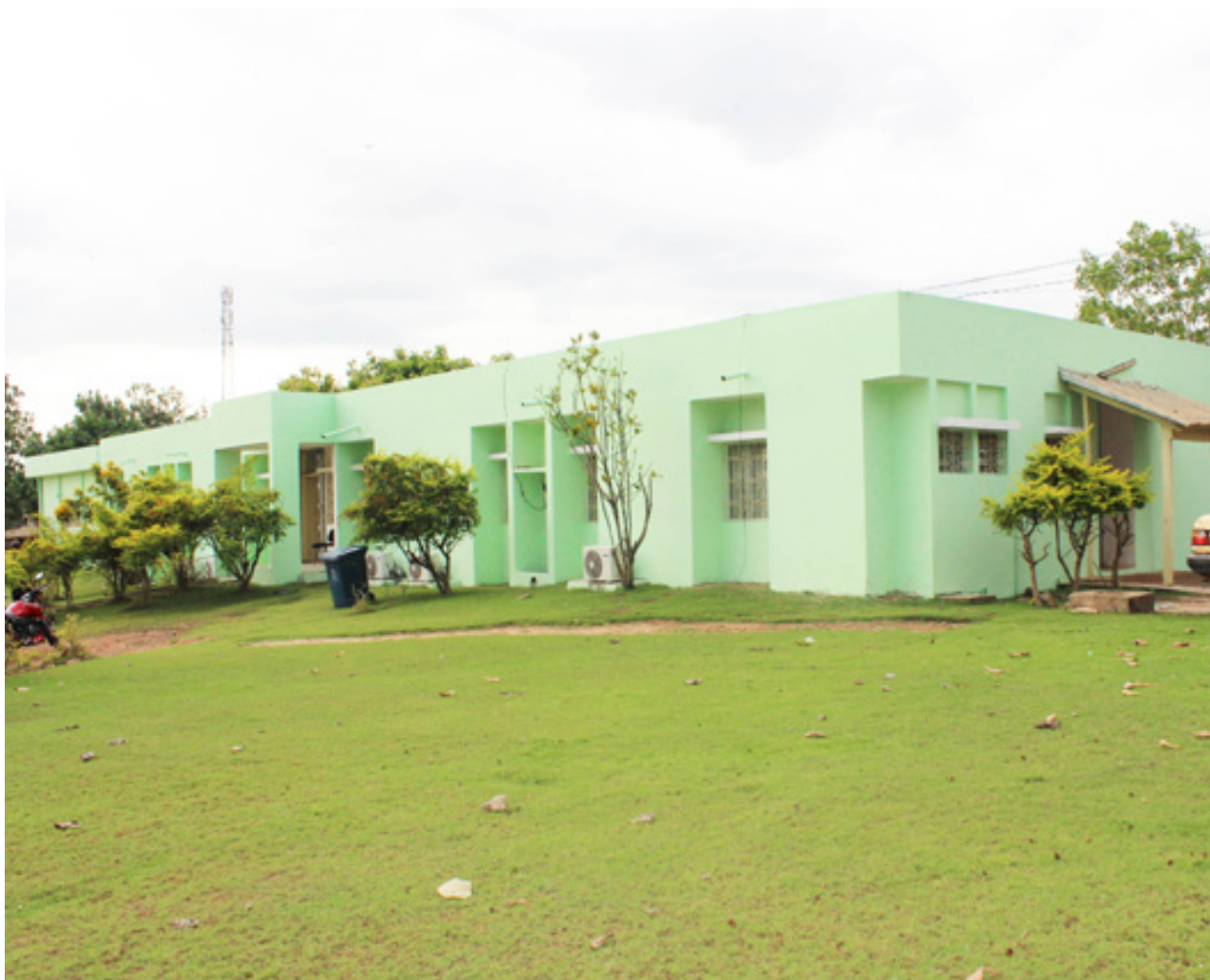
Photo 12 : Une vue de face du siège de la Direction de Zone Sud-ouest à Soubré.
