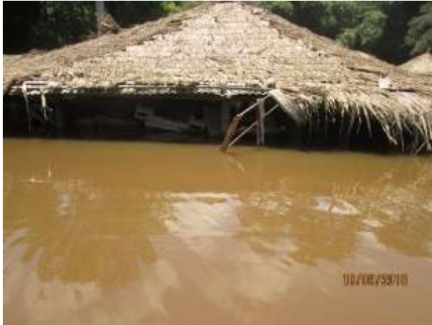
Figure 27 : Restaurant de l'Ecotel inondé
