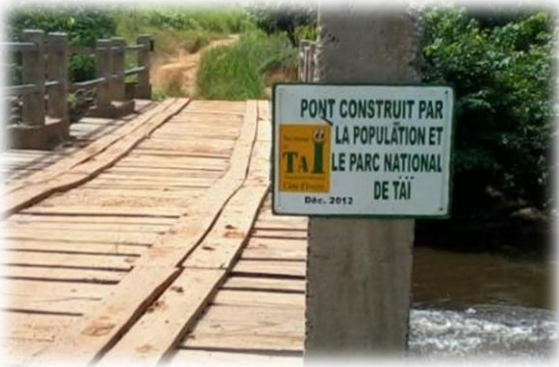
Photo 15 : Pont réhabilité par l'OIPR sur le fleuve San Pedro à Djapadji
