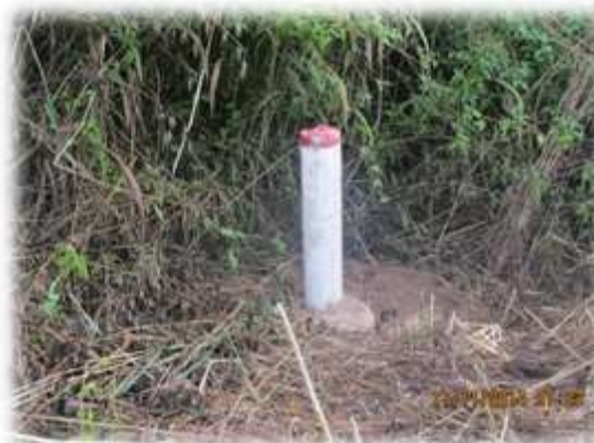
Figure 20. Borne géodésique pour matérialiser les limites du PNC
