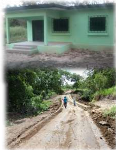
Figure 11. Aménagement d'une piste et réfection des bureaux au PNC
