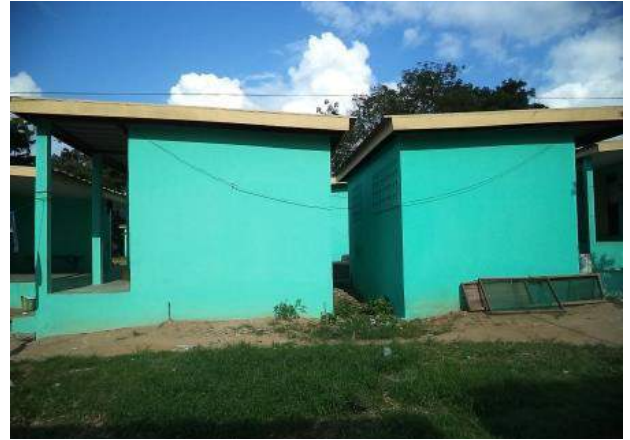
Photo 20 : Des bâtiments réhabilités de la base-vie de Soubré
