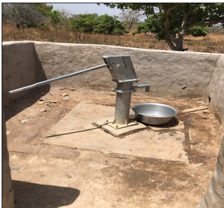
Photo 10 : Exemple d'une pompe hydraulique villageoise existante autour du PNC
