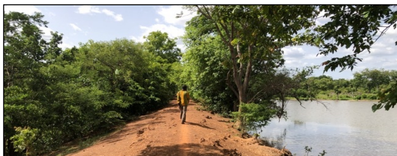
Photo 11 : Exemple d'un barrage agropastoral existant autour du PNC
